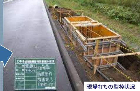
現場打ちの型枠状況
